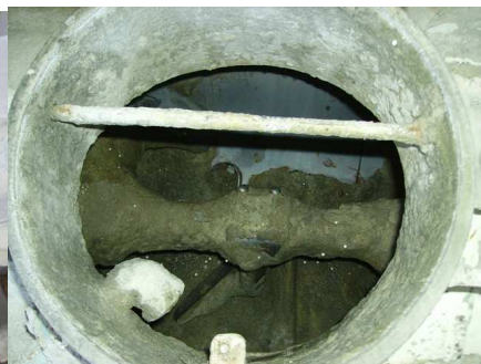
Vista interno macchina
