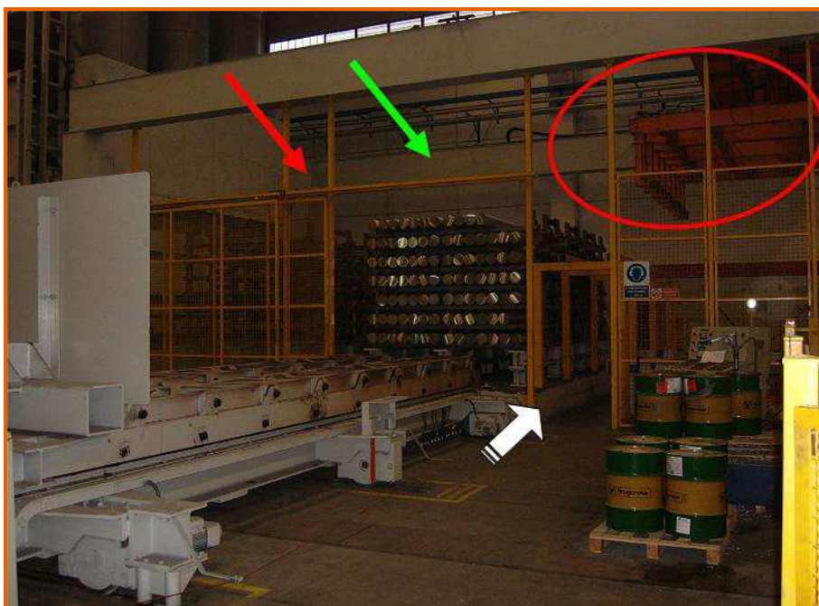
Figura 3: area di preparazione del castello (freccia verde = castello pieno; freccia rossa = castello vuoto); a destra del castello pieno la freccia bianca indica il portale di accesso al retro dell'impianto; indicato in rosso è visibile il carroponete impilatore/disimpilatore di billette
