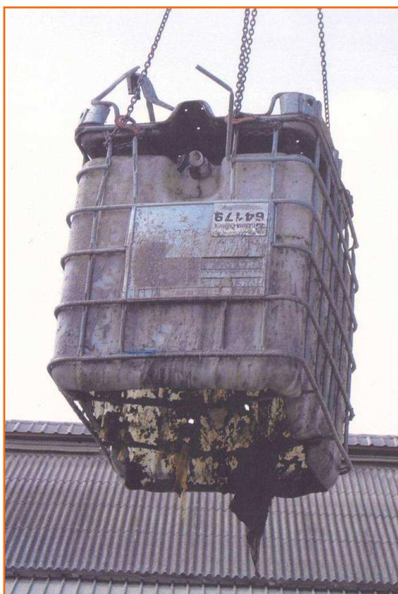
**Figura 6:** fase di recupero del tank caduto all'interno della vasca liquami. Si può osservare l'eliminazione del "cielo" della parte in plastica e bel visibile l'etichetta riportante il n° identificativo definito dal fornitore del prodotto chimico.
