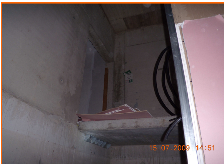
Zona al 5° piano della Torre 3, a fianco dell’ascensore, sprovvista di parapetto: vista dal basso.
