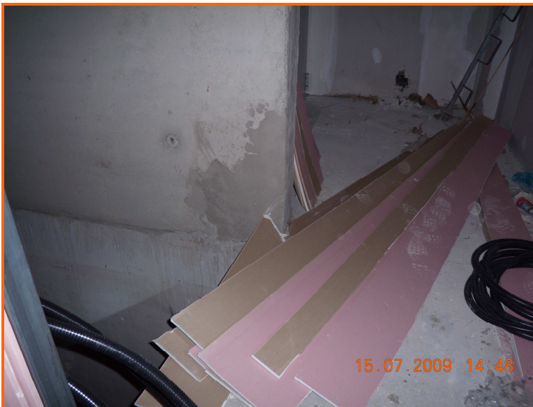
Zona al 5° piano della Torre 3, a fianco dell'ascensore, sprovvista di parapetto: vista laterale da sinistra dallo stesso piano.
