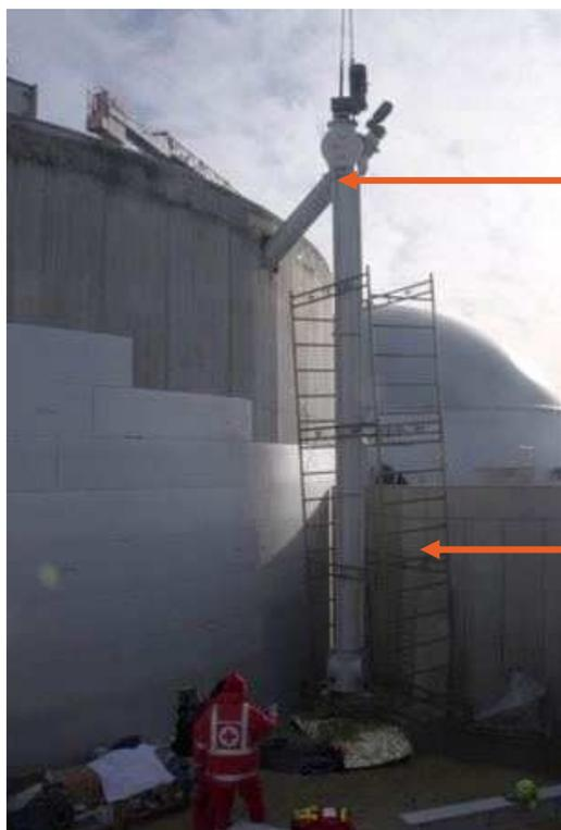
*Braccio inclinato dell'elevatore che entra all'interno del digestore, passando attraverso una feritoia inclinata appositamente lasciata dai carpentieri nella muratura del digestore.*
